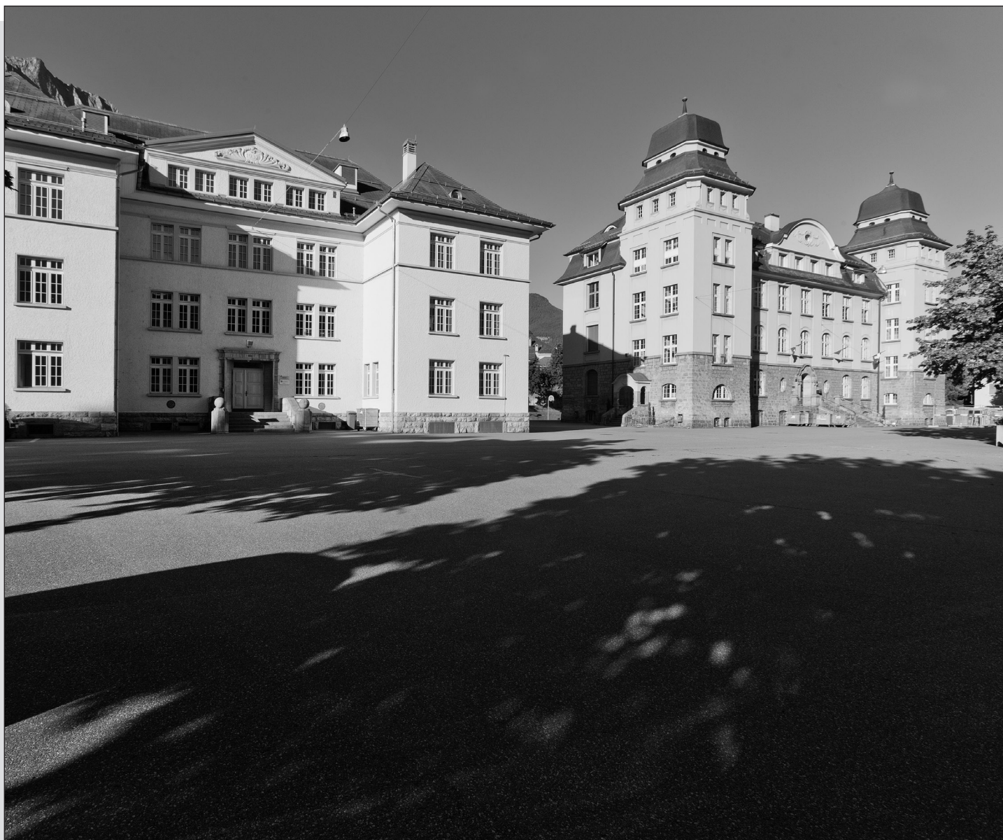
Die grösste Bruttoinvestition ging 2018 in die Sanierung der Schulen (im Bild das Primarschulhaus Brig).
