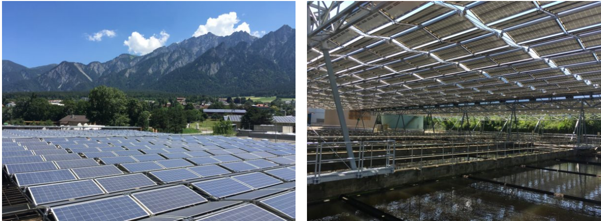
Abbildung 29: PV-Anlage ARA Chur (Quelle IBC Energie Wasser Chur)
