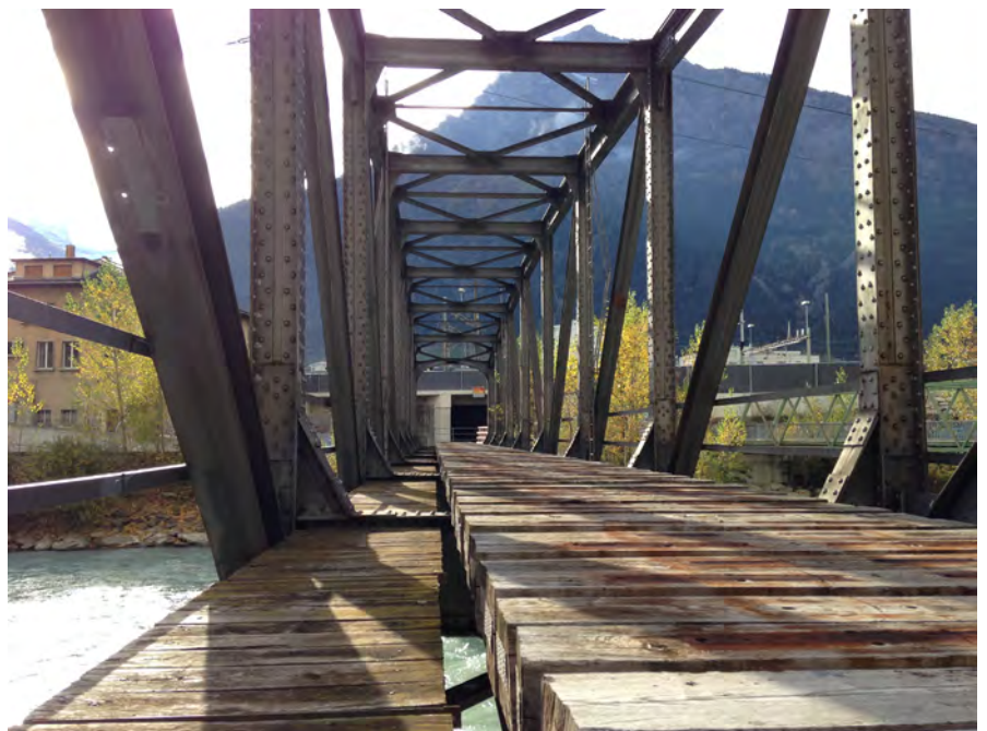
Brücke verbindet die zwei Ortsteile miteinander
