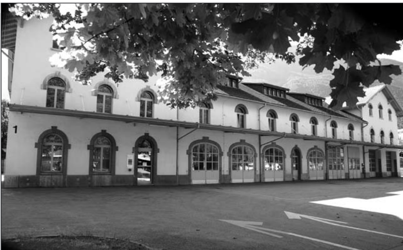
Im Zeughaus-Gebäude 1 soll ein neues Kulturzentrum entstehen.
