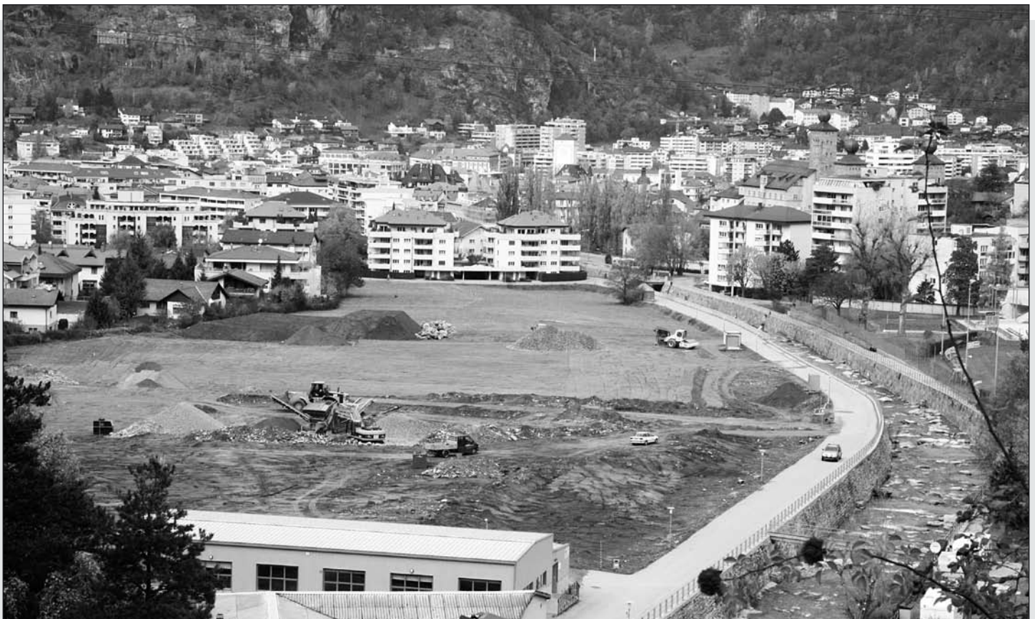
Die Bauarbeiten für die neue Sportarena Geschina sind im Gange.
