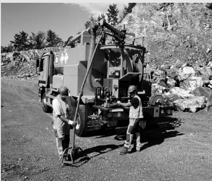
TREMEX®: Emulsionssprengstoff vor Ort mit dem eigenen Mischfahrzeug Pump Truck produziert
