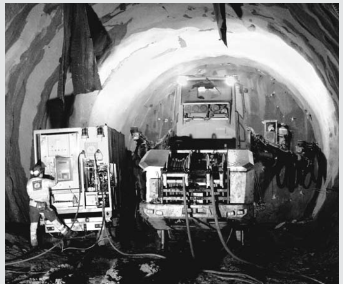
EMULGA®: Emulsionssprengstoff vor Ort mit der MORSE-Pumpeinheit (links im Bild) produziert
