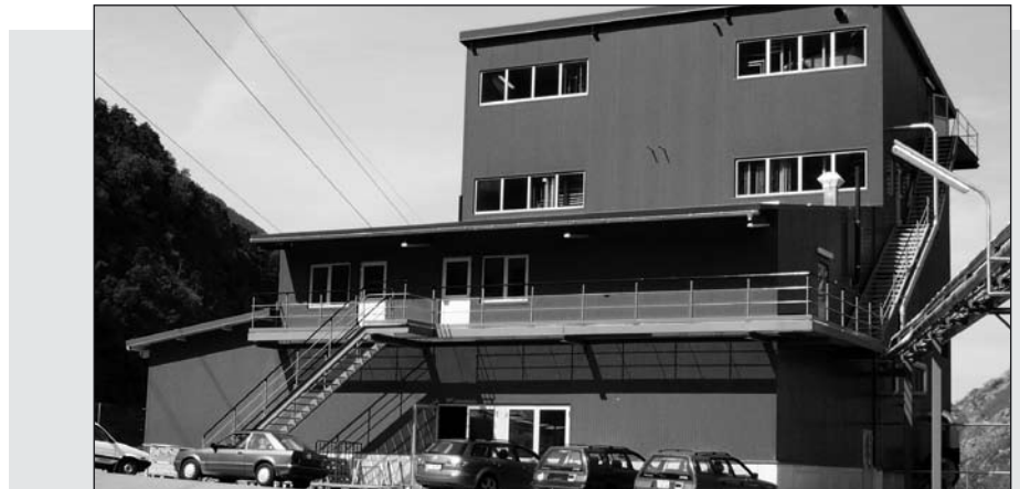
Chemiegebäude zur Herstellung von Feinchemikalien und pharmazeutischen Wirkstoffen
